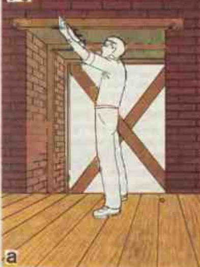
73. Штукатуримые верхнего (а) и бокового (б) оконных откосов
