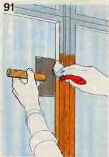
91. Применение предохранительного щитка при окрашивании переплетов
