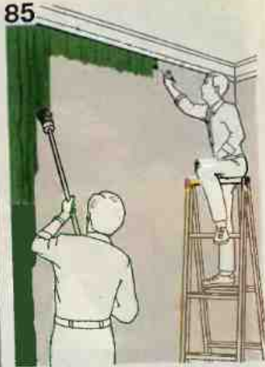
85. Окрашивание верха стены под карнизом ручником
