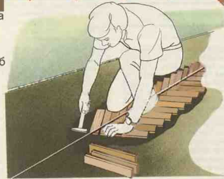
37. Раскладка змейки из паркетных планок и закладка маячной елки
