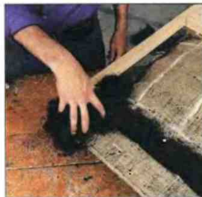
3. При укладке набивки следите за тем, чтобы она распределялась равномерно.
