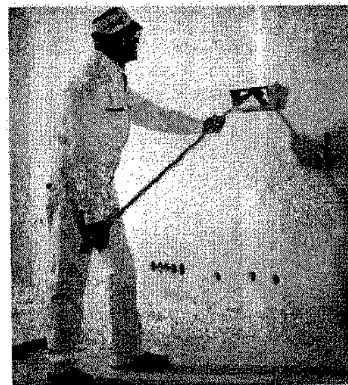
Рис. 4.29. Шпаклевание шва с помощью приспособления для механизированной шпаклевки
