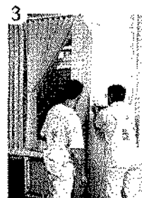
3. и закрепляются шурупами TN 35 к несущим профилям с шагом 25 см. с двух сторон.
