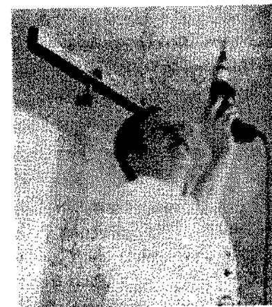
Рис. 3.5. Использование телескопической установки с уровнем для фиксации и выравнивания ГКЛ
