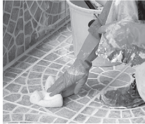
Рис. 5.106. Чистовая зачистка затирки поролоновой губкой
