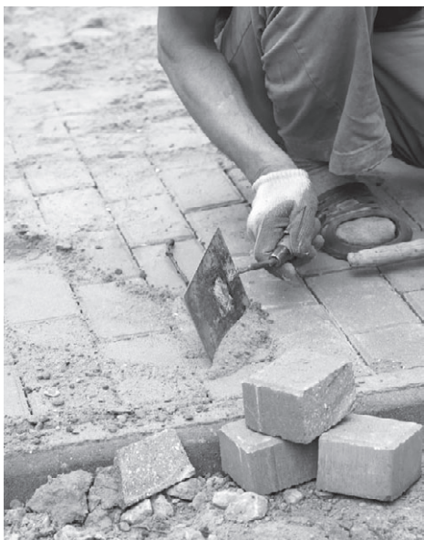
Рис. 10.13. Засыпаем уложенную плитку сухой смесью
