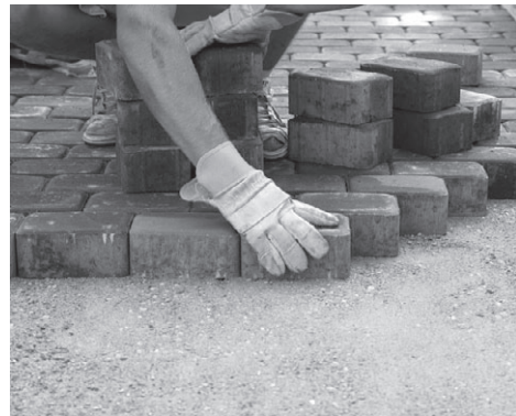
Рис. 10.4. Проще всего укладывать брусчатку
