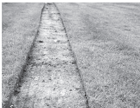
Рис. 10.5. На месте укладки дорожки из плитки снимаем дерн
