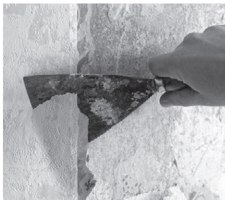
Рис. 4.11. Обои подцепляются в месте стыка
