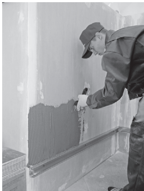
Рис. 5.46. Наносим клей на стену
