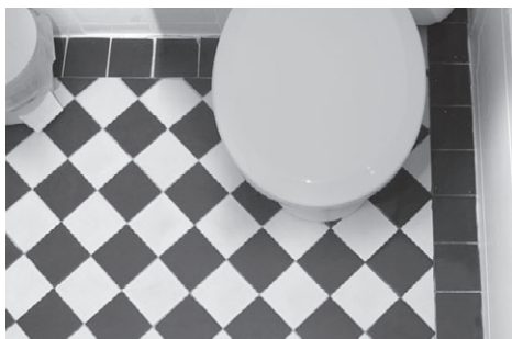
Рис. 5.35. Готовый интерьер санузла с плиткой, выложенной по диагонали с обрамлением из фризового ряда
