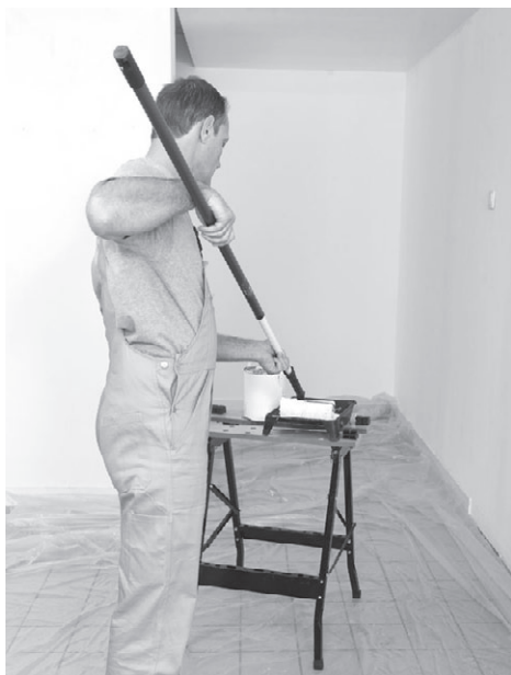
Рис. 5.45. Грунтуем поверхность стен
