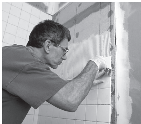
Рис. 4.58. Укладка плитки на конструкцию из гипсокартона
