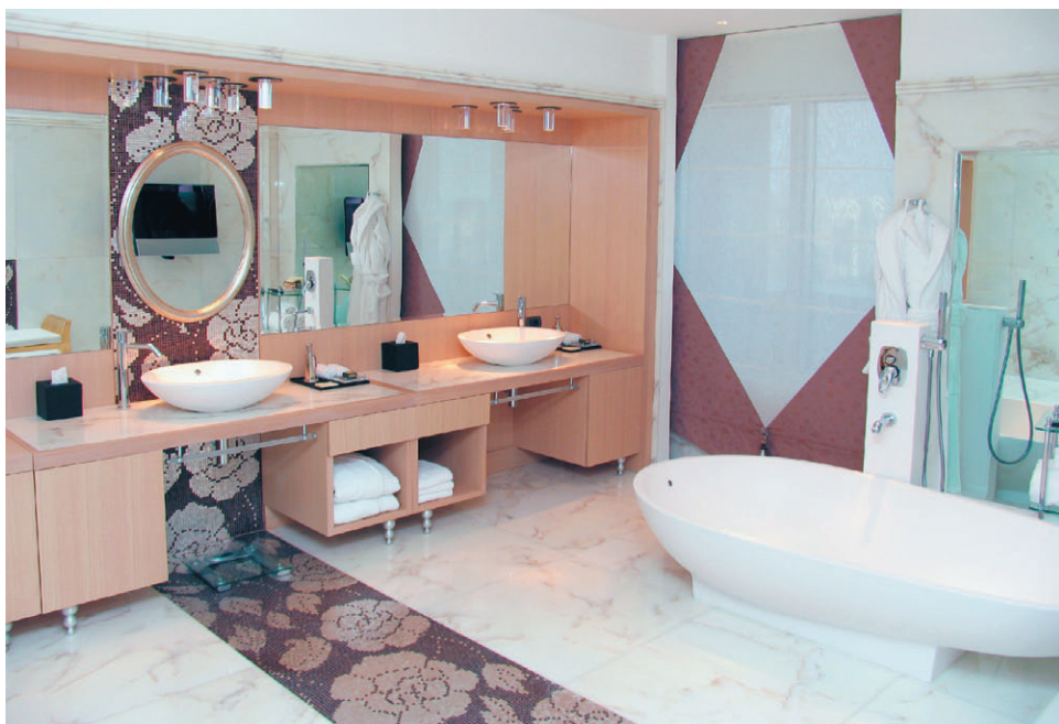
Рис. 3.17. Полоса из плитки небольшого размера переходит со стены на пол
