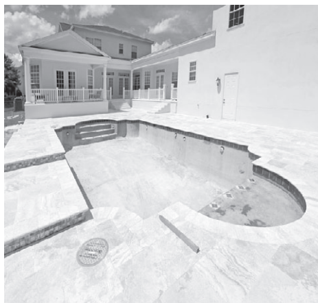
Рис. 5.66. Облицовка бассейна плиткой
