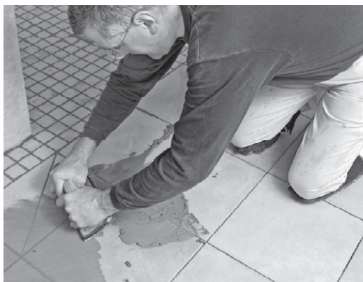
Рис. 5.112. Нанесение затирки в тон керамической плитке
