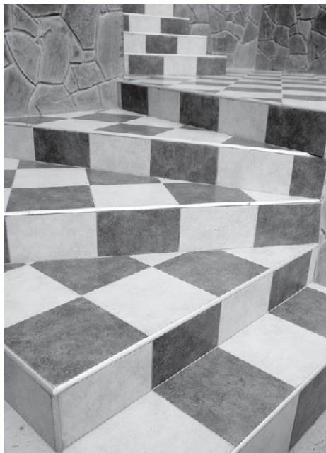
Рис. 5.68. Бетонная лестница, облицованная плиткой
