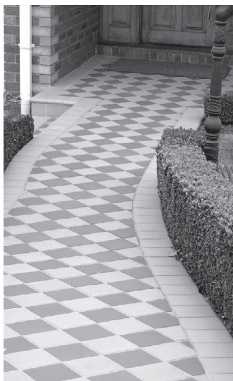
Рис. 2.4. Морозостойкость — важный показатель при устройстве дорожек из плитки
