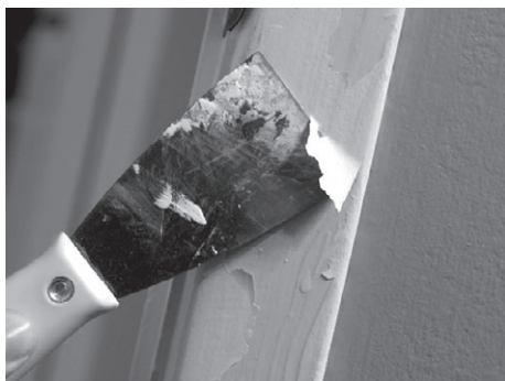
Рис. 4.6. Удаление старой краски с помощью смывки и шпателя
