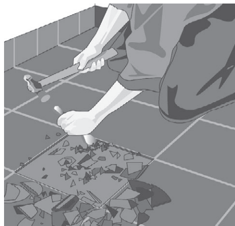
Рис. 4.2. Скалываем старую напольную плитку с помощью зубила и молотка
