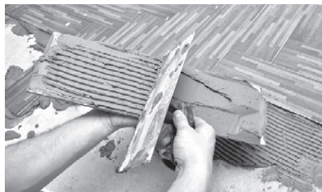
Рис. 5.12. Промазываем клеем саму плитку
