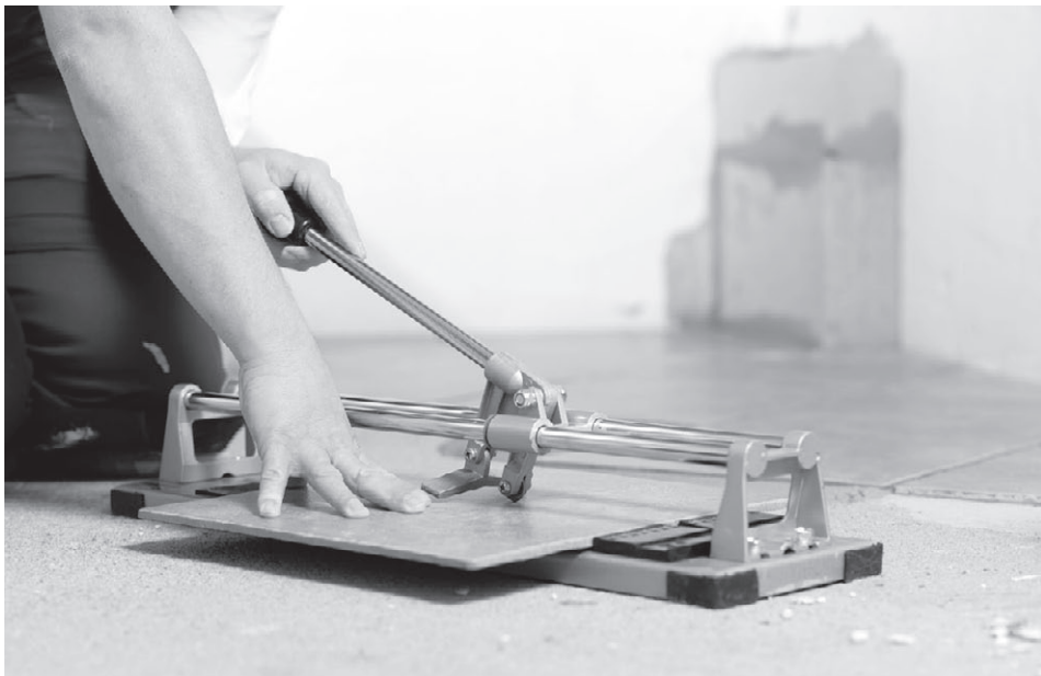
Рис. 5.122. Резка плитки с помощью плиткореза
