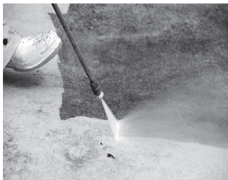
Рис. 4.13. Очистка поверхности пола от мусора струей воды
