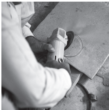
Рис. 5.127. Фигурная резка плитки с помощью болгарки
