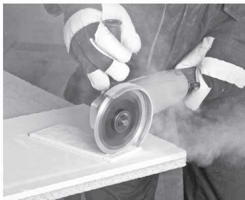
Рис. 5.125. Резка плитки с помощью болгарки
