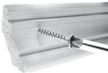
Рис. 7.15. Монтаж деревянного плинтуса
