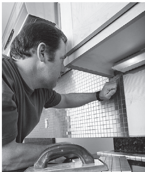
Рис. 5.63. Кухонный фартук укладывается до монтажа мебели
