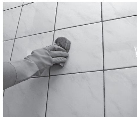
Рис. 5.107. После высыхания затирки сухой налет убирают влажной ветошью
