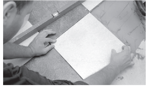
Рис. 5.29. Прижимаем плитку к основанию пола
