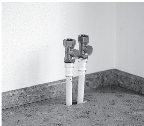
Рис. 9.12. Высверливаем электродрелью либо выпиливаем лобзиком отверстия
