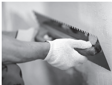
Рис. 4.45. Выравнивание стены с помощью штукатурной смеси и широкого шпателя
