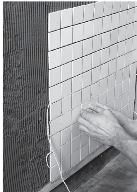
Рис. 5.44. Используем вспомогательную планку для укладки плитки
