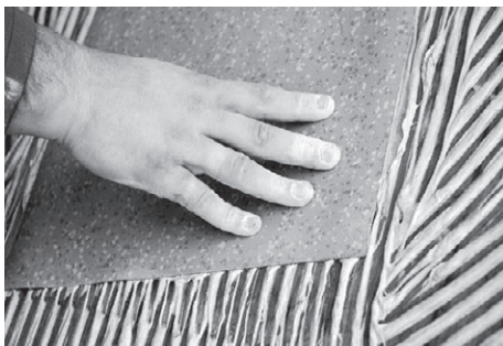
Рис. 9.38. Прижимаем и держим плитку
