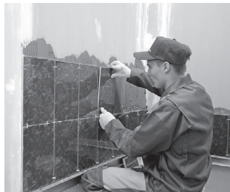
Рис. 5.50. Укладываем второй ряд
