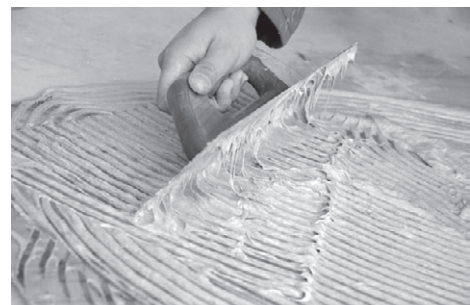
Рис. 9.36. Наносим мастику на основание пола
