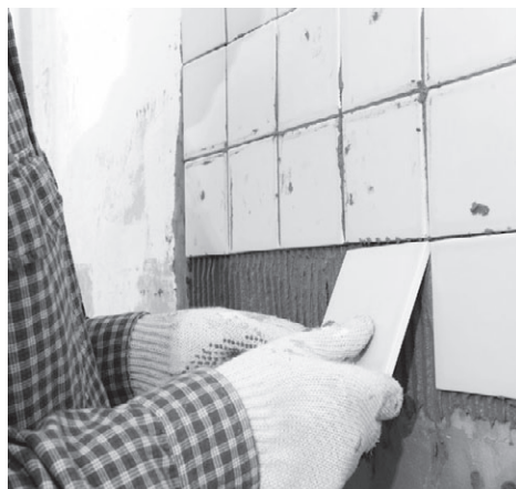
Рис. 5.57. Укладка плитки «сверху вниз»
