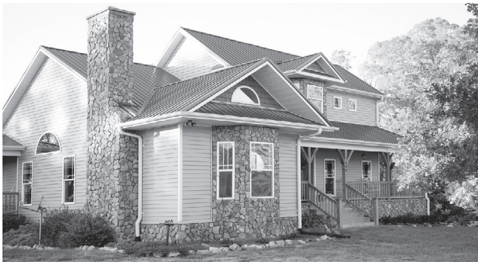
Рис. 8.18. Для отделки фасада здания следует выбирать камень повышенной морозостойкости
