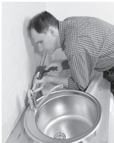
Рис. 5.55. Обработка шва в месте стыковки керамического покрытия и столешницы силиконовым герметиком
