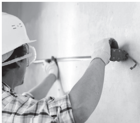
Рис. 4.56. Измерение диагонали стены с помощью рулетки
