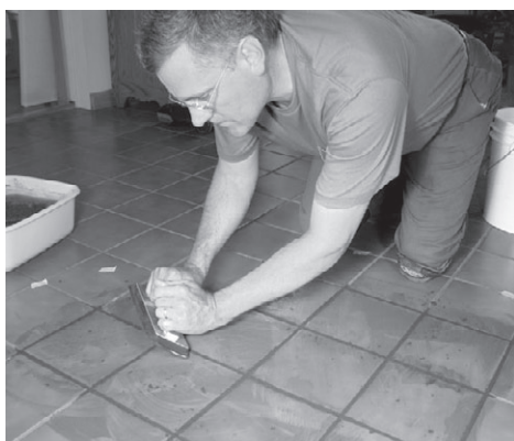
Рис. 5.104. Нанесение затирки с помощью шпателя на резиновой основе
