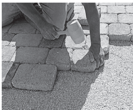
Рис. 10.12. Утрамбовываем плитку в основание с помощью деревянной киянки
