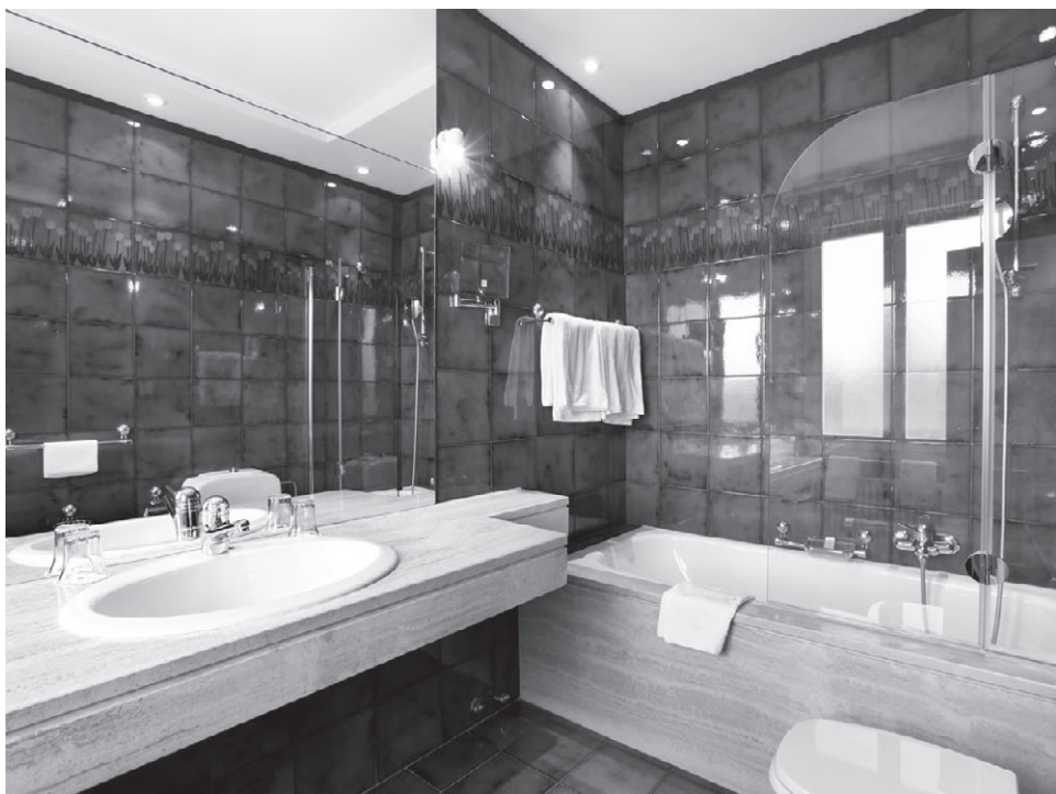
Рис. 2.25. Ванная комната, облицованная стеклянной плиткой (см. вклейку)
