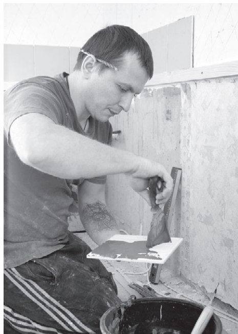
Рис. 5.47. Наносим клей на кафельную плитку
