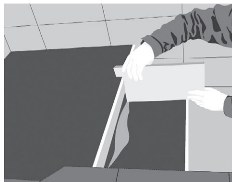
Рис. 5.70. Убираем излишки клея шаблоном
