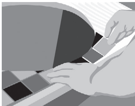
Рис. 5.97. Укладываем маленькие отрезки мозаики
