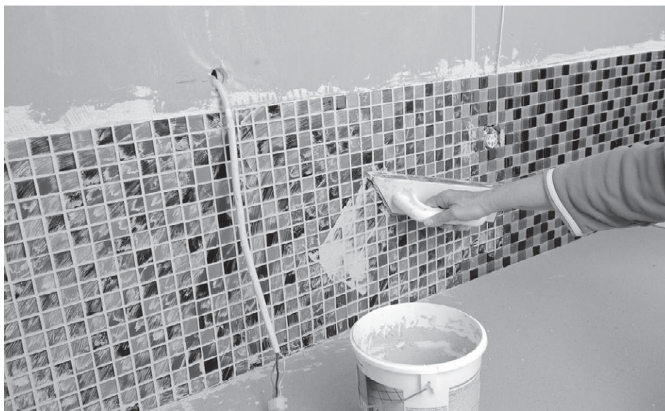
Рис. 5.88. Нанесение затирки на мозаику
