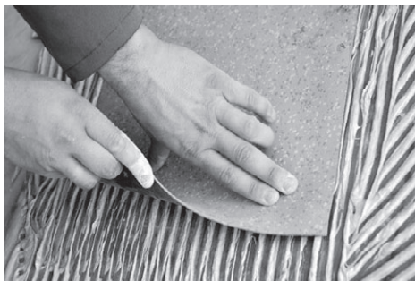
Рис. 9.37. Приклеиваем плитку
