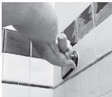
Рис. 5.105. Нанесение затирки на стену производится так же, как и на пол
