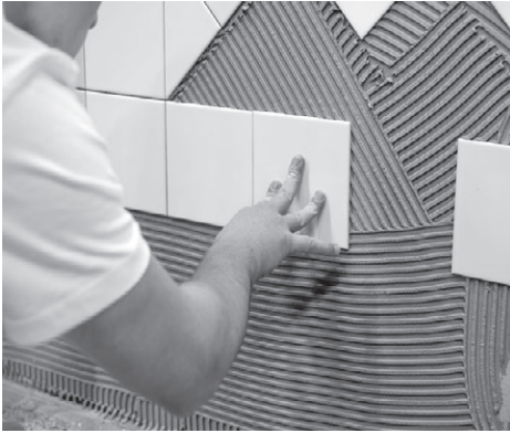
Рис. 5.58. Для лучшего схватывания плитку прижимают к стене
