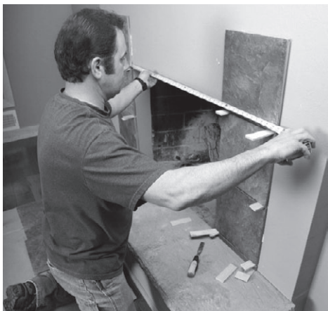
Рис. 5.65. Облицовка поверхности камина
