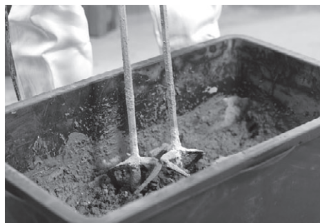
Рис. 4.35. Изготовление раствора для стяжки с помощью дрели с миксерной насадкой
