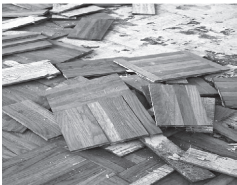
Рис. 4.12. Старый паркет разбирается на отдельные плашки
