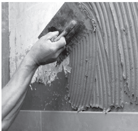
Рис. 5.56. Нанесение клеевого состава на стену
