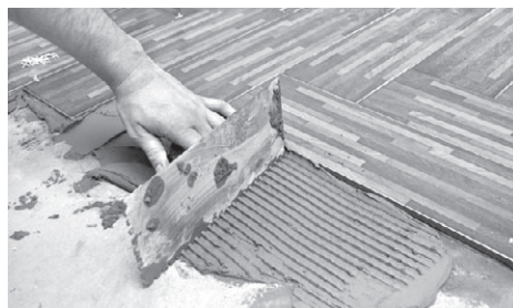
Рис. 5.11. Наносим клей на основание пола и разравниваем его
