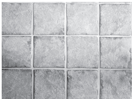
Рис. 5.2. Шахматная укладка плитки
