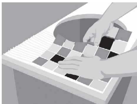
Рис. 5.94. Укладываем цельные листы мозаики, прижимая их рукой к поверхности столешницы
