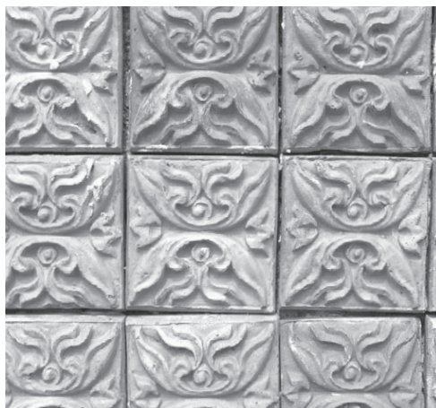
Рис. 2.37. Малейшие неточности могут привести к неровным швам и некачественной укладке
