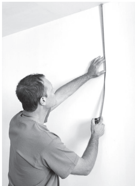
Рис. 2.46. Измерение стен для расчета необходимого количества плитки
