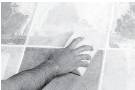
Рис. 6.5. Убираем лишнюю затирку
