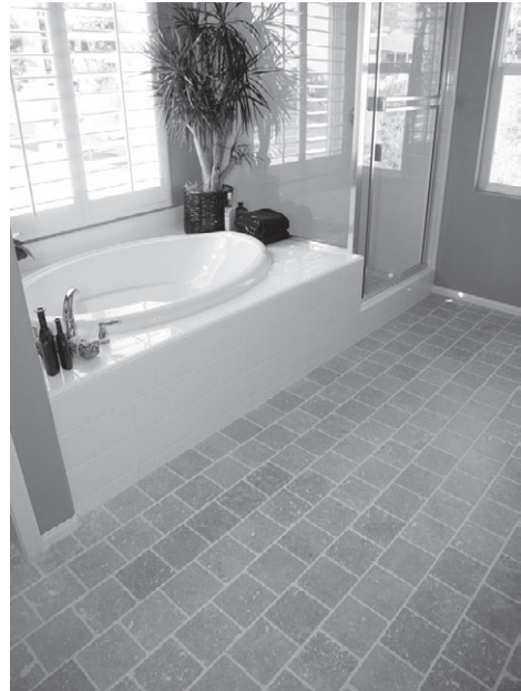
Рис. 5.5. Укладка плитки разных размеров способом «вразбежку»
