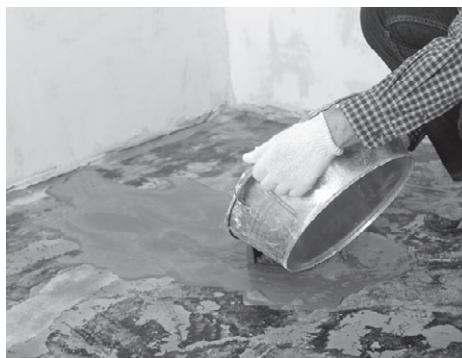
Рис. 4.42. Раствор наливают постепенно, начиная от стен помещения
