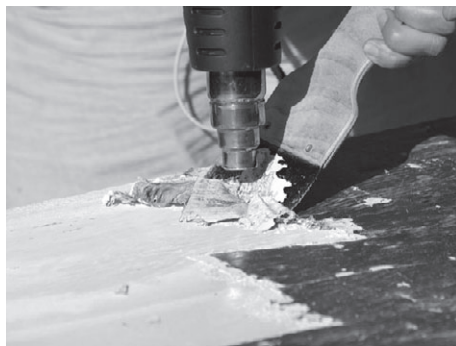
Рис. 4.7. Удаление старой краски с поверхности пола с помощью строительного фена
