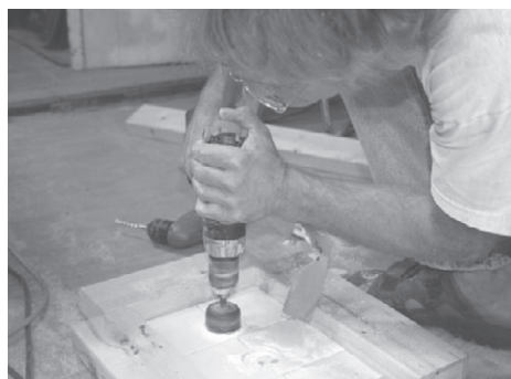
Рис. 5.132. Использование кольцевой пилы для сверления отверстия
