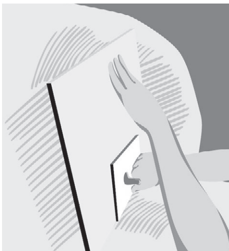
Рис. 5.80. Простукиваем мозаику шпателем на резиновой основе для лучшего приклеивания
