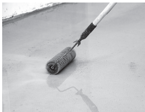
Рис. 4.44. Финишер наносится на стяжку игольчатым валиком
