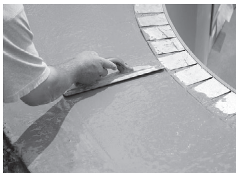
Рис. 7.7. Заделываем зазор цементным раствором
