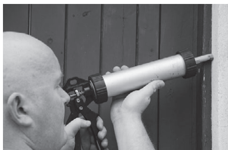
Рис. 5.117. Для заделки швов используется герметик
