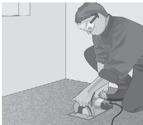
Рис. 4.4. Шлифуем поверхности пола
