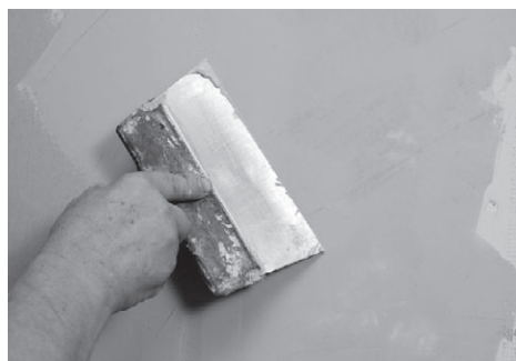
Рис. 4.63. Стыки плит из гипсокартона заделывают шпатлевкой
