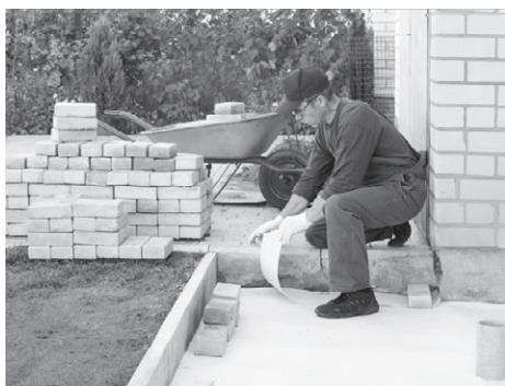
Рис. 10.6. Устанавливаем бортовой камень — ограждение дорожки
