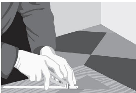
Рис. 9.39. Разрезаем ПВХ-плитку с помощью ножа
