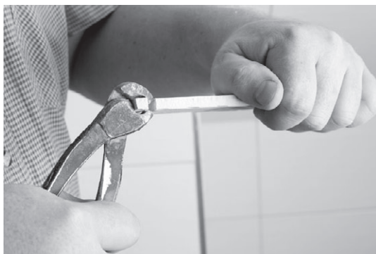
Рис. 5.128. Чистовая подгонка фрагмента под нужную форму с помощью обычных кусачек
