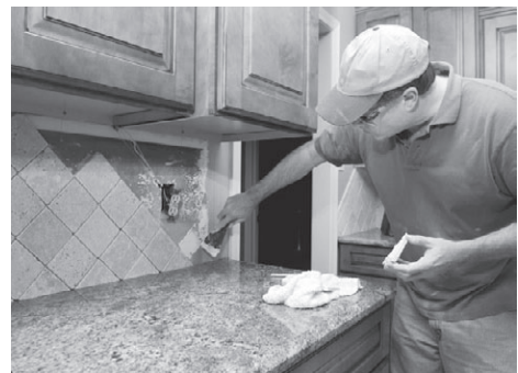
Рис. 5.62. Укладка плитки для кухонного фартука по диагонали
