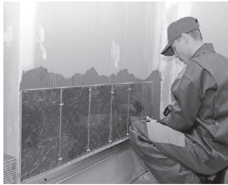
Рис. 5.49. Устанавливаем плитку первого горизонтального ряда
