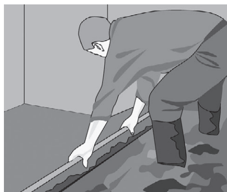
Рис. 4.37. Выравнивание стяжки правилом
