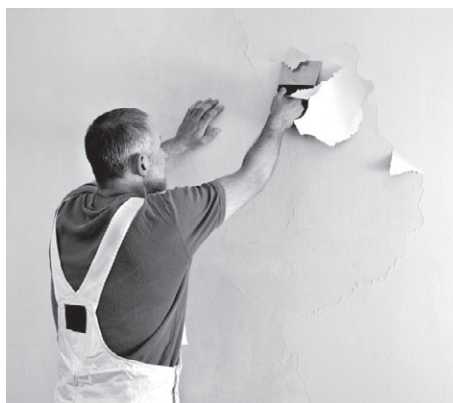
Рис. 4.10. Удаление краски с помощью шпателя
