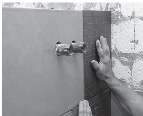
Рис. 5.64. Обход водопроводных труб требует особого мастерства
