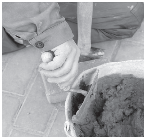
Рис. 5.109. Самостоятельное изготовление затирки
