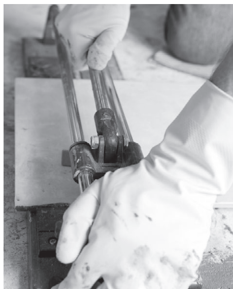
Рис. 7.5. Отрезаем плитку нужного размера
