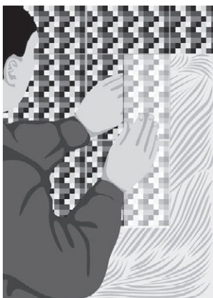
Рис. 5.85. Укладываем мозаику на сетчатой основе лицевой стороной наружу
