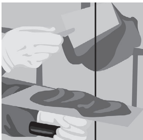
Рис. 4.53. Установка марок из раствора
