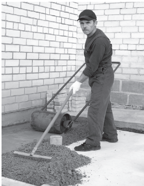
Рис. 10.8. Разравниваем слой песка на геотекстиле
