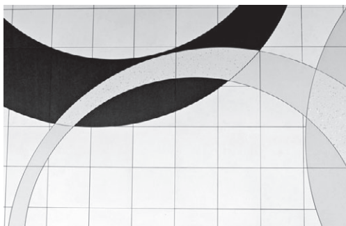
Рис. 3.9. Художественная резка простой кафельной плитки
