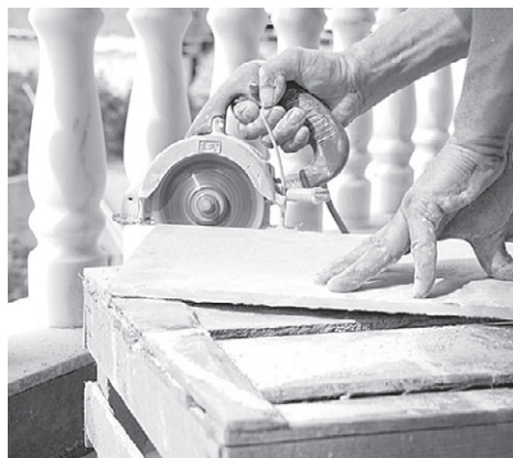
Рис. 8.9. Резка мраморной плитки
