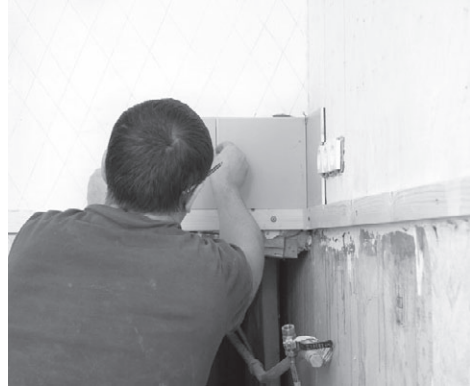
Рис. 5.48. Прикладываем плитку к стене
