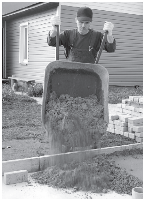
Рис. 10.7. Делаем засыпку из щебня или песка на геотекстиль
