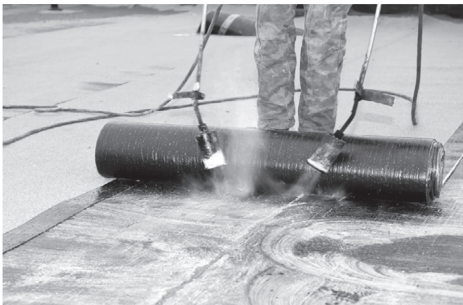
Рис. 4.20. Укладываем гидроизоляционный слой из рулонного рубероида
