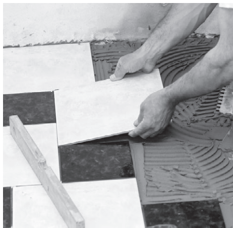
Рис. 8.7. Монтаж мраморных плиток
