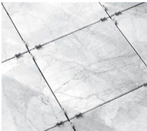
Рис. 8.8. Использование разделительных крестиков при укладке мраморной плитки
