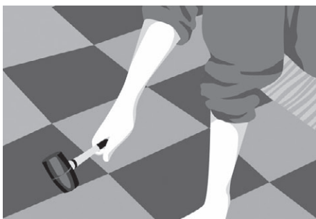
Рис. 9.40. Уложенные плитки простукиваем резиновым молотком
