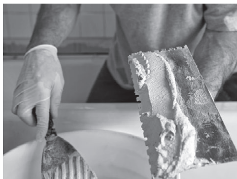
Рис. 4.46. Оштукатуривание производится с помощью смеси на основе гипса
