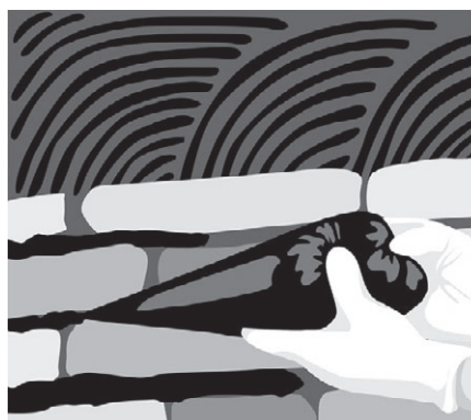
Рис. 8.23. Заполняем раствором большие расстояния между камнями
