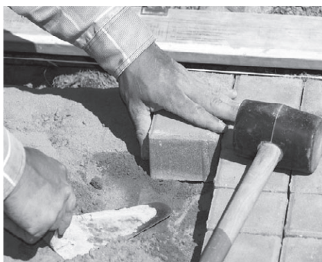
Рис. 10.11. Укладываем тротуарную плитку на раствор цемента
