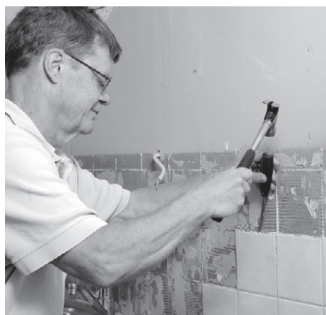
Рис. 4.47. Удаление старой плитки
