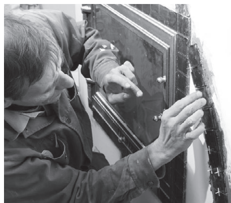
Рис. 4.59. Установка дверцы
