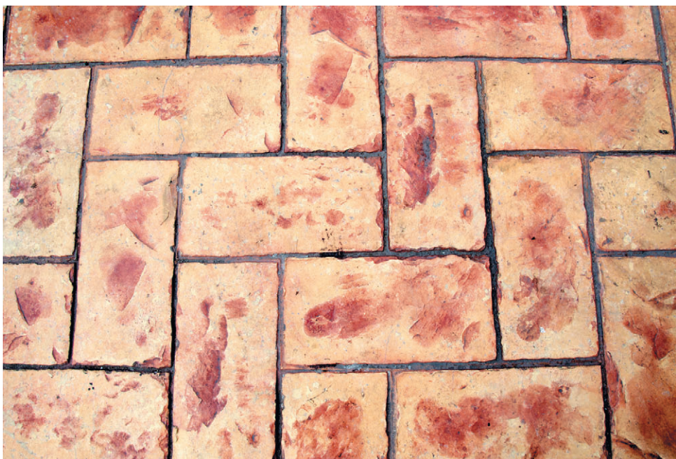
Рис. 5.7. Плитка, уложенная «елочкой»
