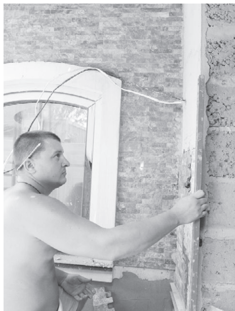
Рис. 8.20. Проверяем ровность стены правилом
