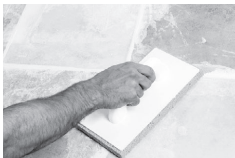
Рис. 6.4. Заполняем швы новым раствором
