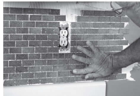
Рис. 5.61. Сложный обход розеток может вызвать вопросы у малоопытных плиточников
