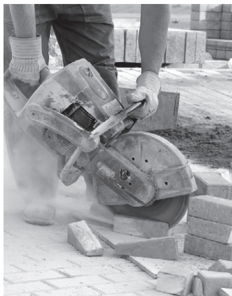
Рис. 10.14. Надрезаем тротуарную плитку болгаркой
