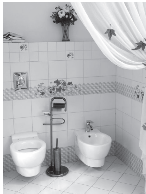
Рис. 5.6. Укладка плитки на полу «по диагонали»
