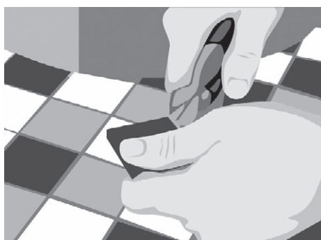
Рис. 5.99. Отламываем небольшой кусочек мозаики кусачками
