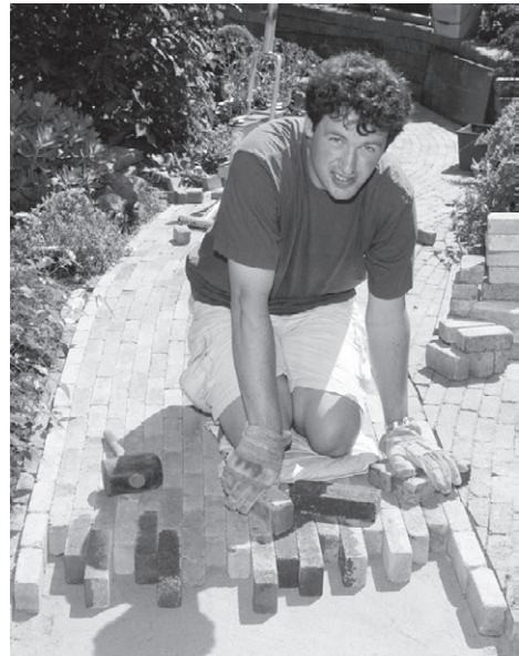
Рис. 10.3. Укладка тротуарной плитки — работа сложная и новичку вряд ли будет под силу
