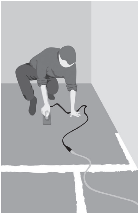
Рис. 9.34. Укладываем ПВХ-плитку на чистый, сухой и ровный пол
