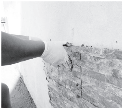
Рис. 8.21. Выкладываем камнем основную поверхность стены
