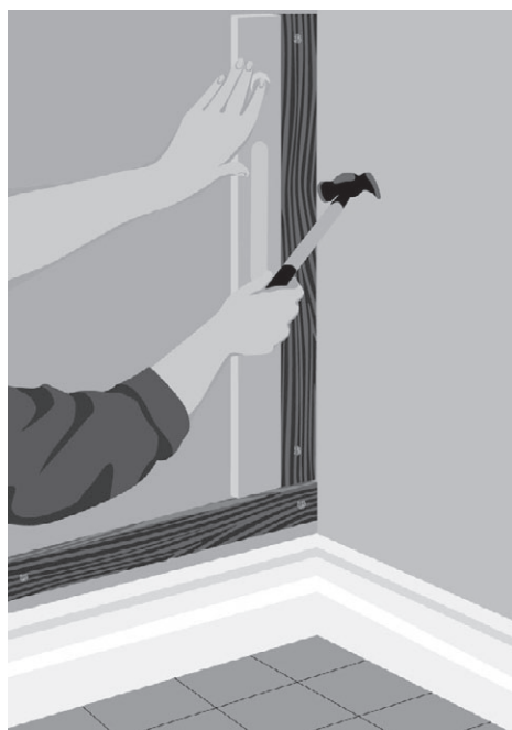
Рис. 5.42. Прикладываем профиль по горизонтальной линии вдоль стены
