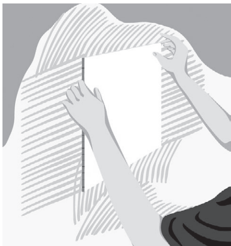
Рис. 5.79. Наклеиваем мозаику бумажной стороной к себе
