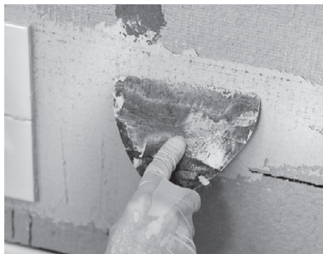
Рис. 4.14. Мелкие трещины заделываются ремонтным раствором
