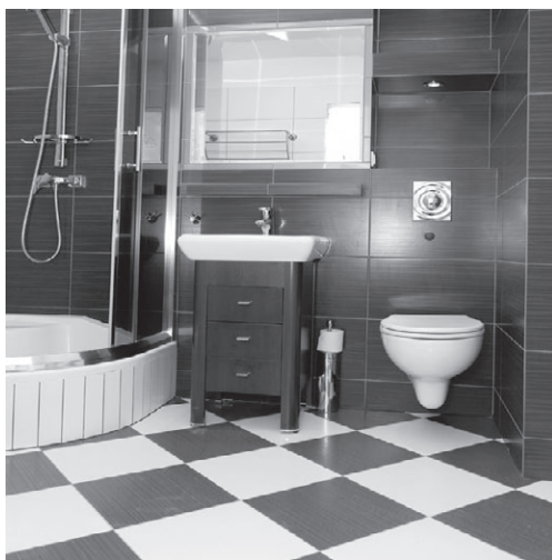
Рис. 3.7. Шахматная укладка контрастной плитки под углом
