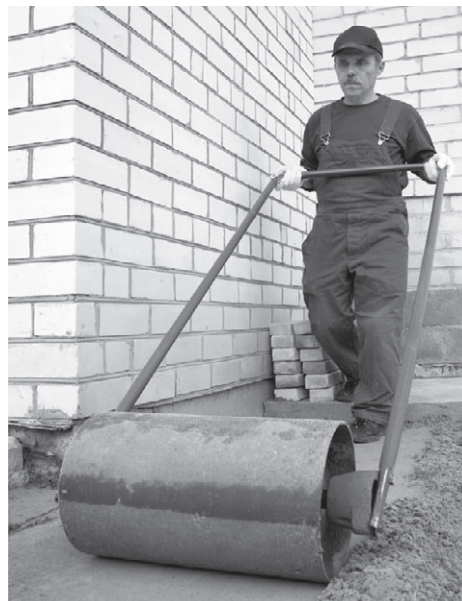
Рис. 10.9. Утрамбовываем основание для дорожки
