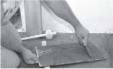
Рис. 5.28. Наносим клей на внутреннюю поверхность плитки
