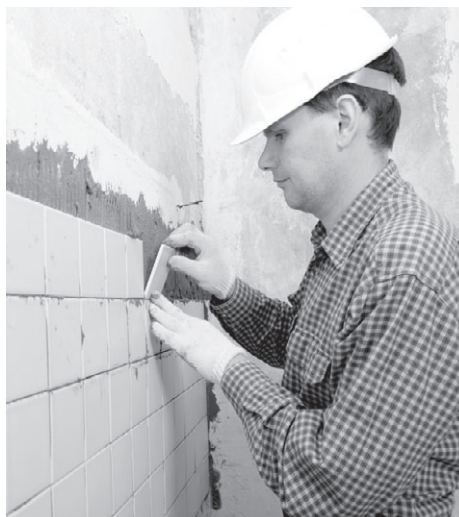
Рис. VI. Доверять работу по укладке плитки можно только мастерам с опытом работы
