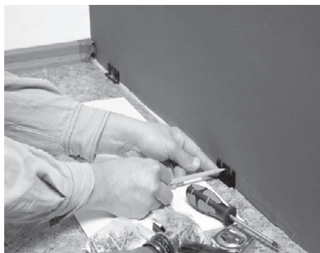
Рис. 7.23. Отмечаем карандашом место крепления самореза
