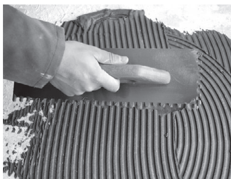
Рис. 5.26. Нанесение клея на основание зубчатым шпателем
