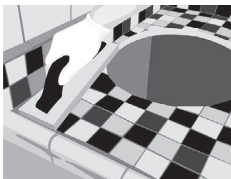
Рис. 5.101. Покрываем мозаику затиркой в тон плиткам с помощью резинового шпателя
