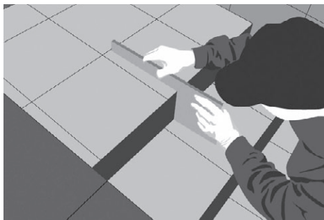
Рис. 5.75. Выравниваем поверхность подступенков
