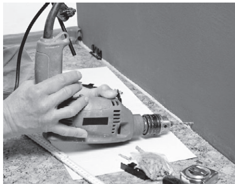
Рис. 7.25. Монтируем скобы для крепления плинтусов из МДФ
