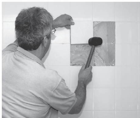
Рис. II. Каждый этап в укладке плитки важен и требует больших трудозатрат
