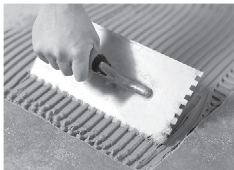
Рис. 5.16. Нанесение плиточного клея
