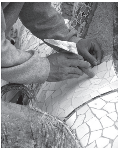
Рис. 5.67. Мозаичная техника позволяет пройти сложные участки по укладке плиткой
