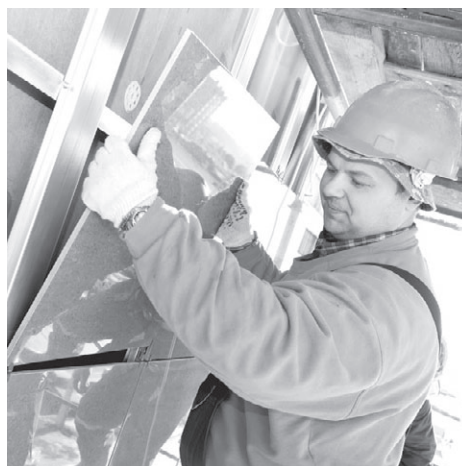
Рис. 2.3. Плитка широко используется для облицовки фасадов
