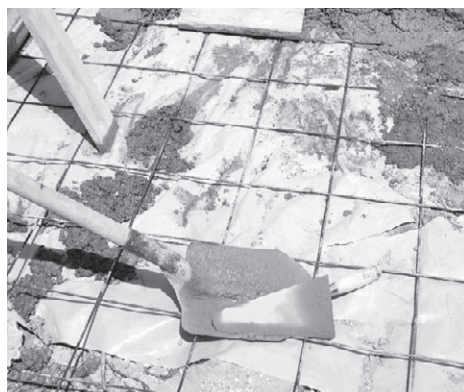
Рис. 4.36. Заливка раствора в виде полос
