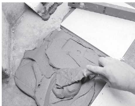
Рис. 5.14. Укладка плитки на цементно-песчаный раствор
