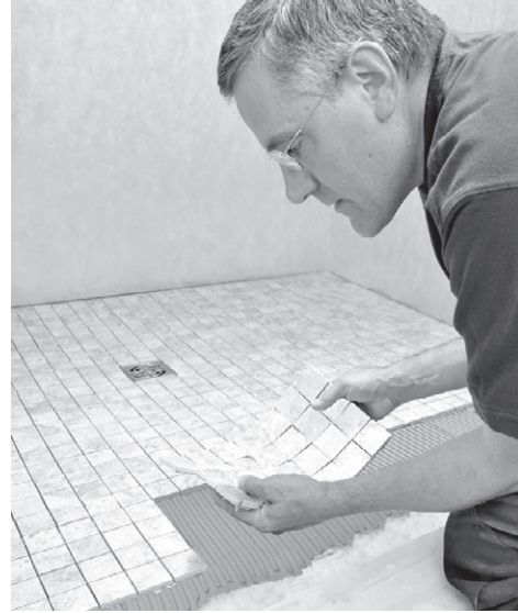
Рис. 3.38. Укладка плитки 5×5 см
