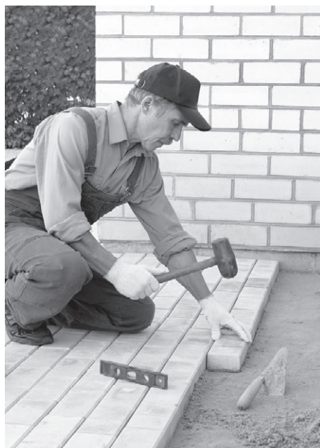
Рис. 10.10. Подбиваем тротуарную плитку резиновым молотком
