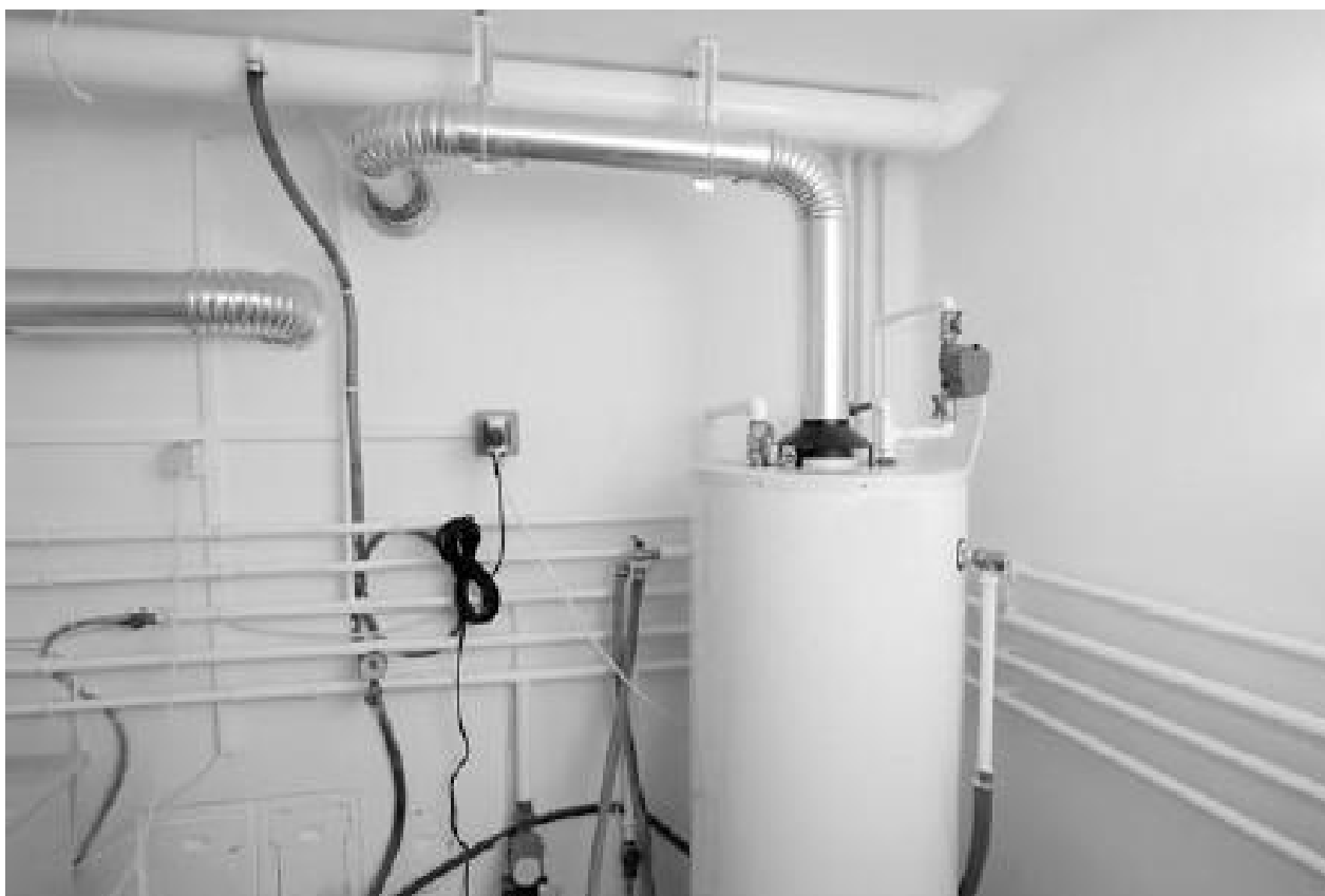
Рис. 1.24. Газовый отопительный котел
