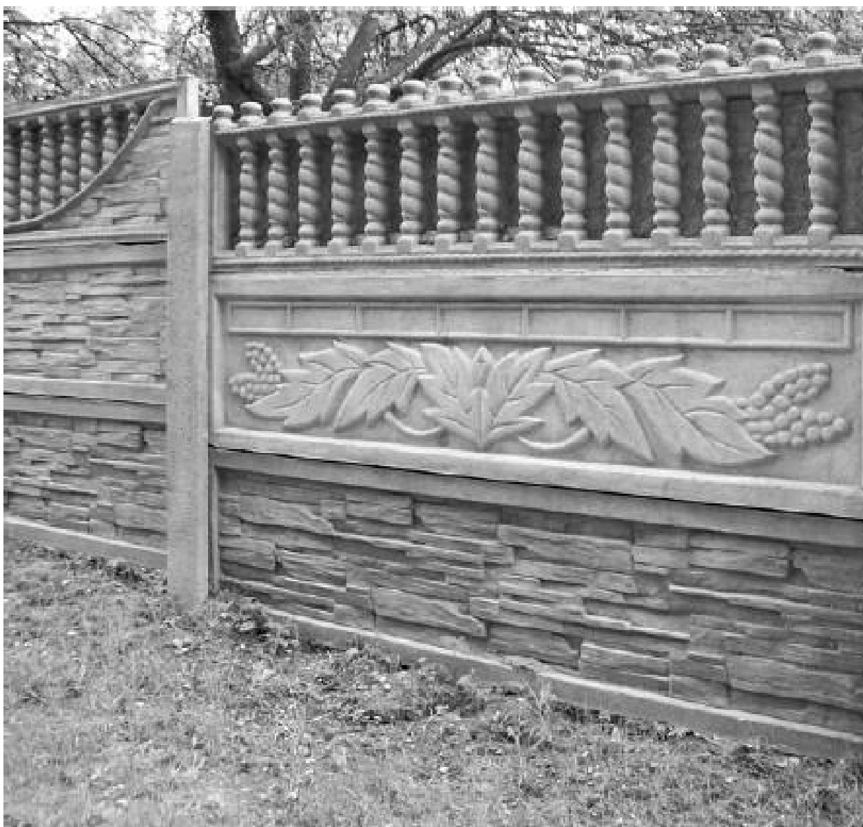
Рис. 6.11. Ограда из бетонных панелей
