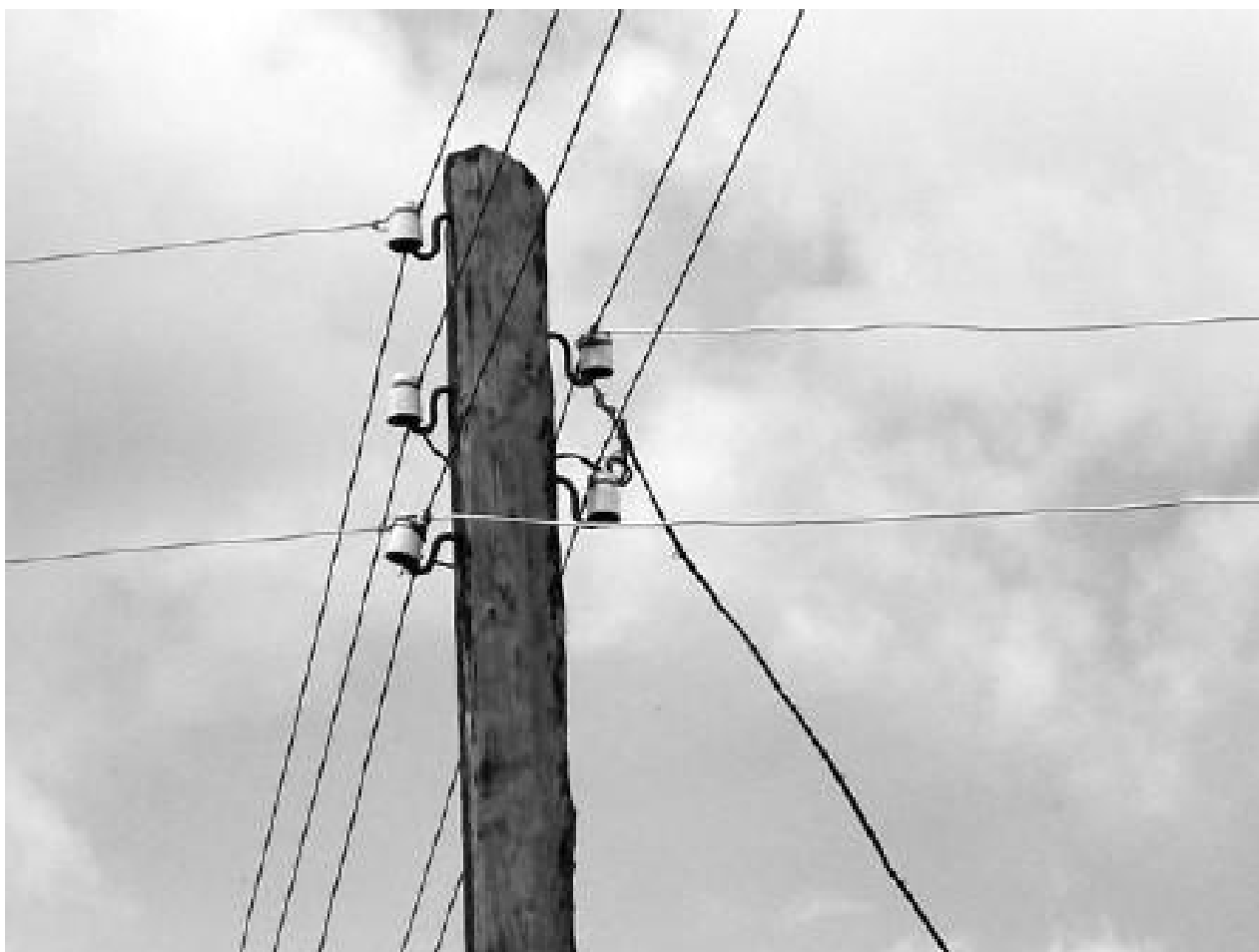
Рис. 1.19. Воздушная линия электроснабжения: отводы от централизованной системы
