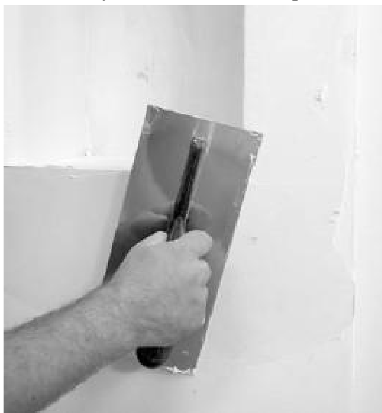
Рис. 8.1. Нанесение шпатлевки
