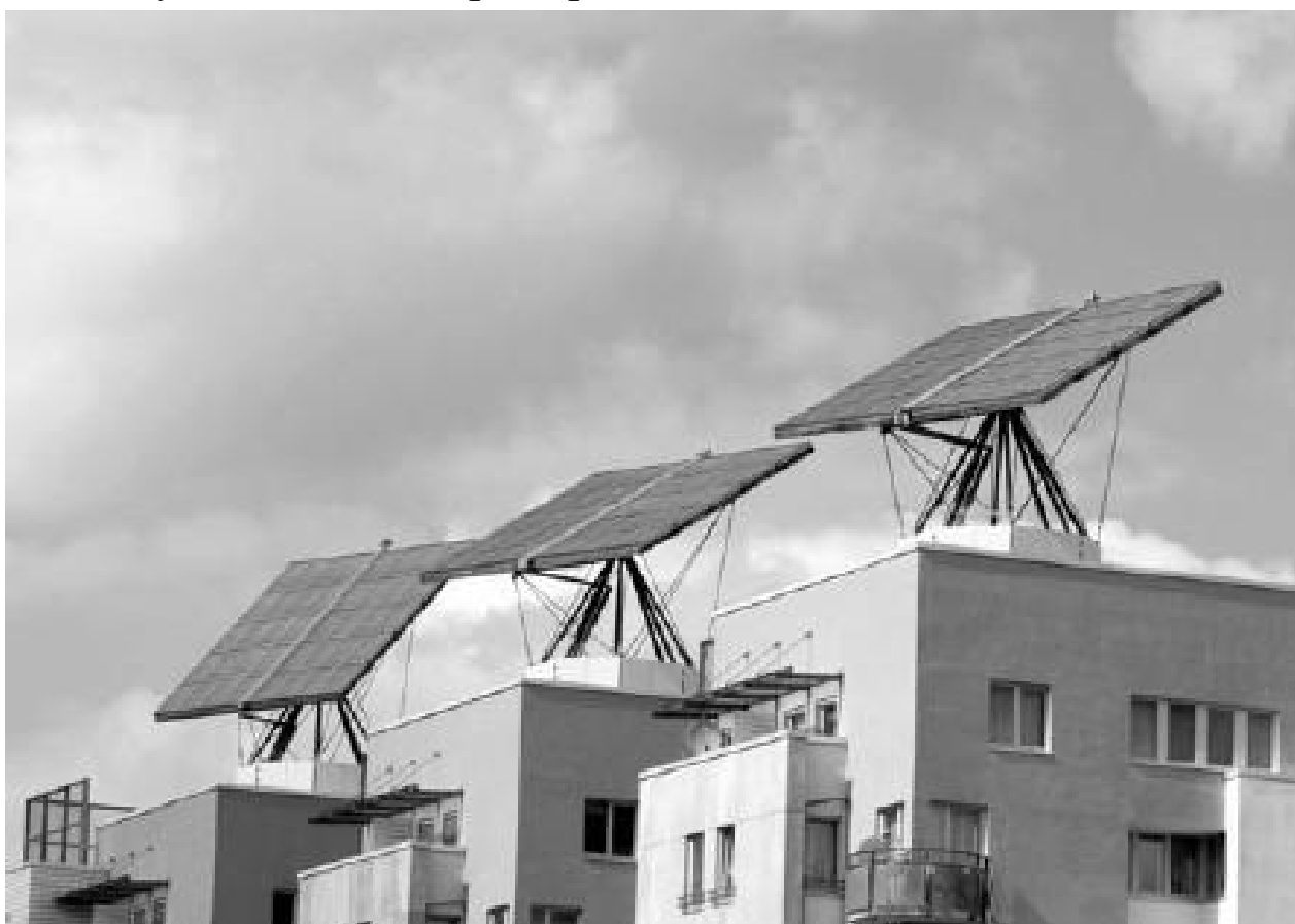
Рис. 1.17. Размещение солнечных батарей на плоской крыше
