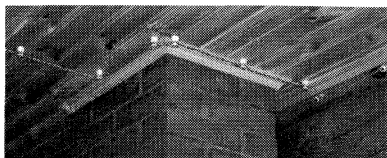
Рис. 4.17. Потолочная проводка на керамических роликах
