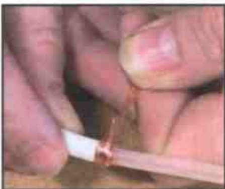
3 Намотайте медные проводки на изоляцию
