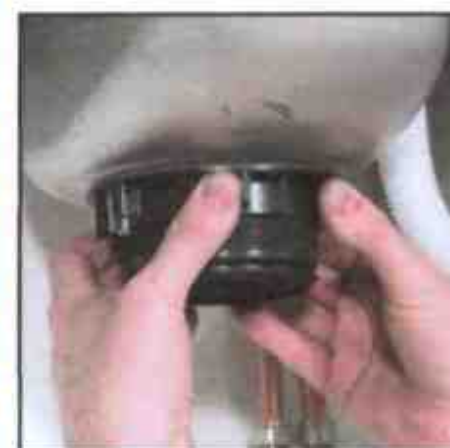
2 Затяните крепежную гайку слива
