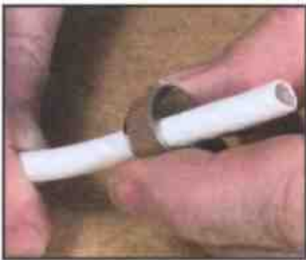
1 Наденьте фиксирующее кольцо на кабель
