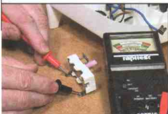
3 Щупами касайтесь контактов термовыключателя
