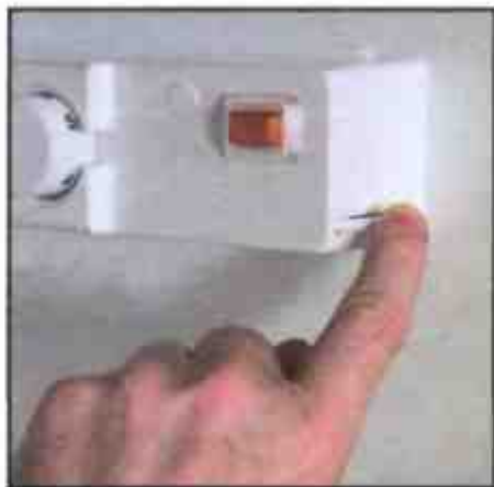
Несколько раз нажмите на выключатель – возможно, его заело
