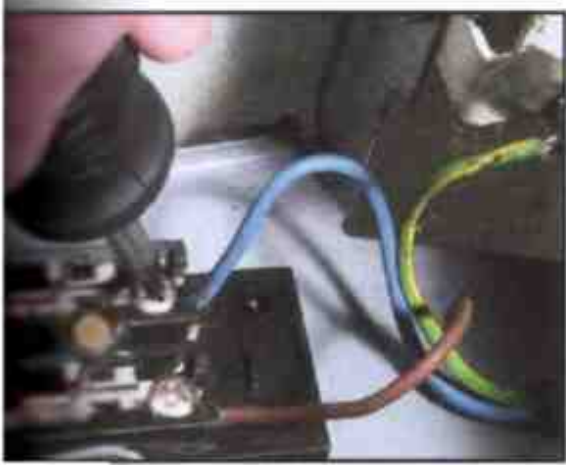
Шнур, подсоединенный к винтовым клеммам, вы сможете заменить самостоятельно
