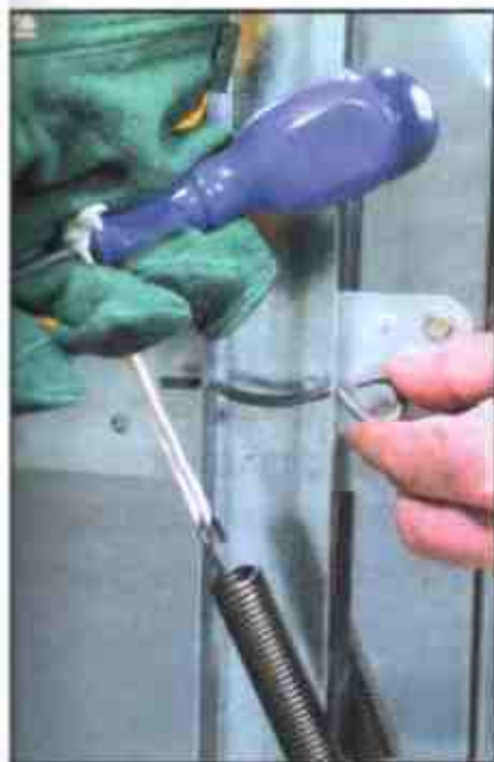
2 Передвиньте шпильку, чтобы усилить натяжение
