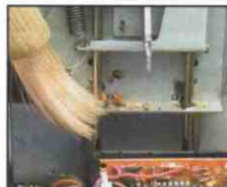
Очистите подъемный механизм
