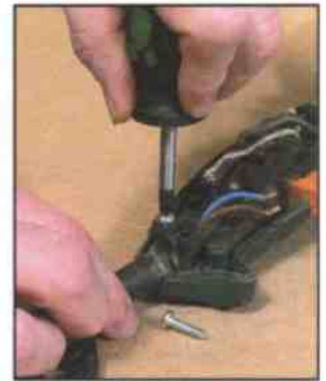
Отсоедините и замените поврежденный шнур
