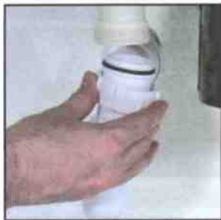
1 Снимите сифон и промойте его
