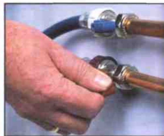
Откройте вентили горячей и холодной воды
