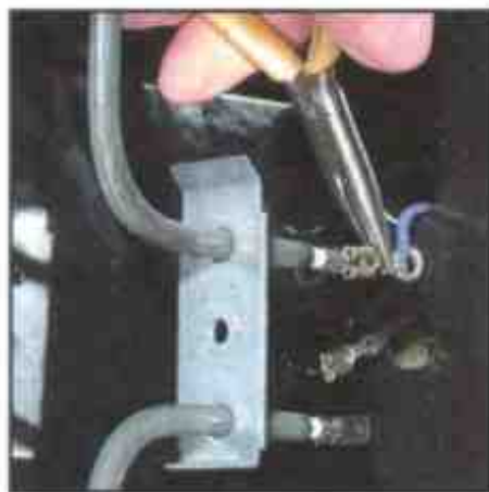
3 Снимите наконечники проводов с контактов
