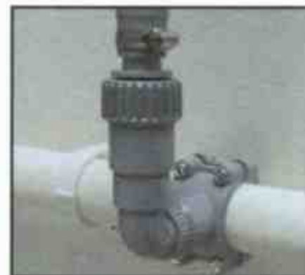
Выпускное устройство предупреждает обратное сифонирование
