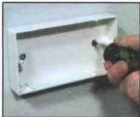
3 Прикрепите к стене монтажную коробку
