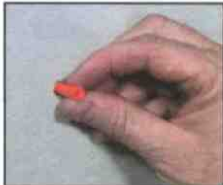
2 Просверлите в стене отверстия и вставьте в них дюбели
