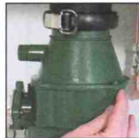
1 Проверьте протечку прокладки
