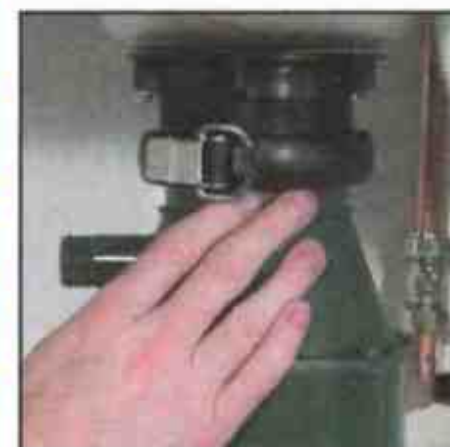
1 Вода может протекать под хомутом
