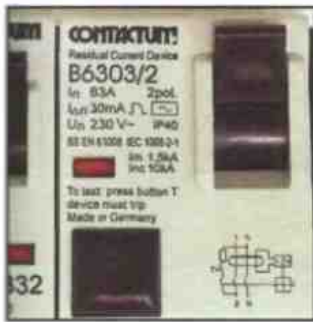
Главный выключатель со встроенным ВДТ
