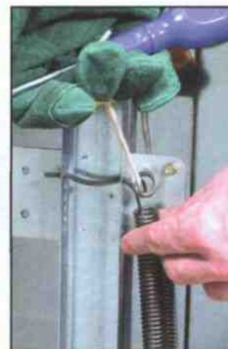
3 Установите пружину на место
