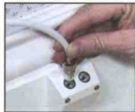
7 Вставьте в сплиттер новый кабель
