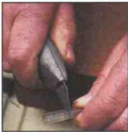
1 Обрежьте затвердевший конец трубки и подсоедините ее к выключателю
