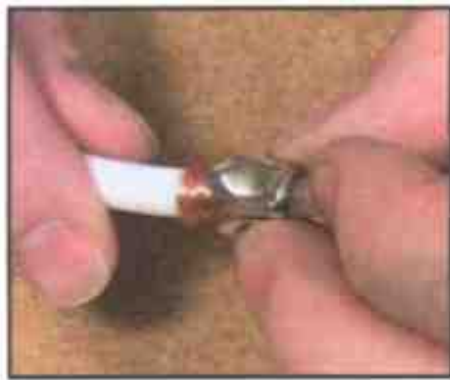
4 Закройте медные проволочки захватом
