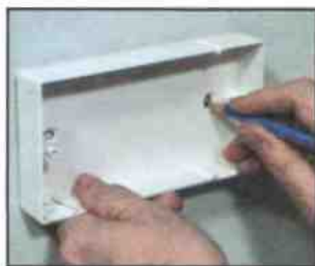
1 Разметьте на стене крепежные отверстия
