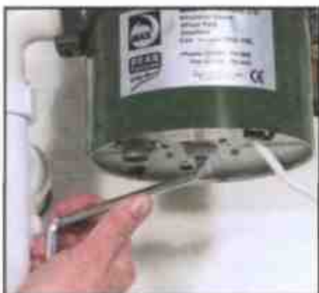
1 Поворачивайте диск ключом-шестигранником
