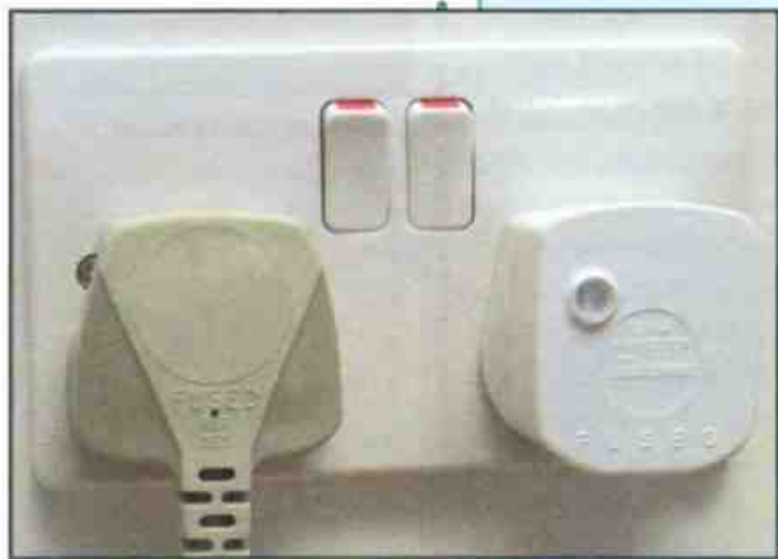
Вилка с защитой от перенапряжения в двойной розетке
