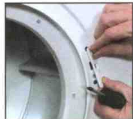
Замените изношенную ответную накладку защелки
