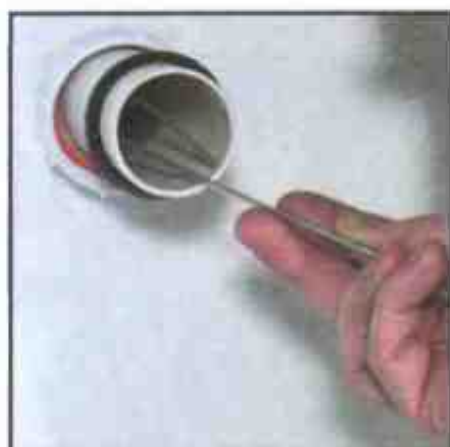
2 Прочистите прямой участок выпускной трубы канализации
