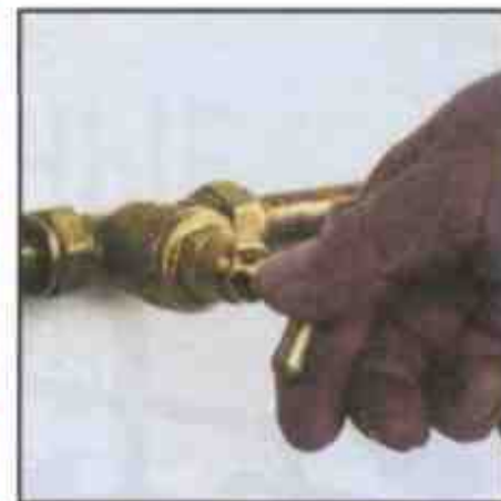
Перекройте воду запорным вентилем
