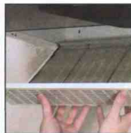
1 Снимите воздухозаборную решетку
